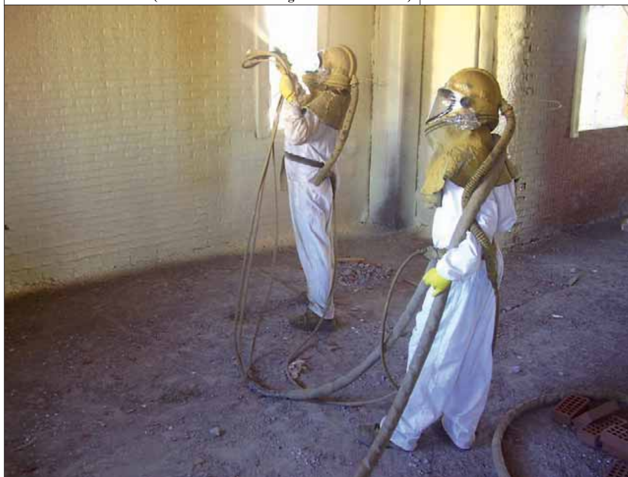
Primo strato di isolante (sono ancora visibili le giunzioni dei laterizi)
