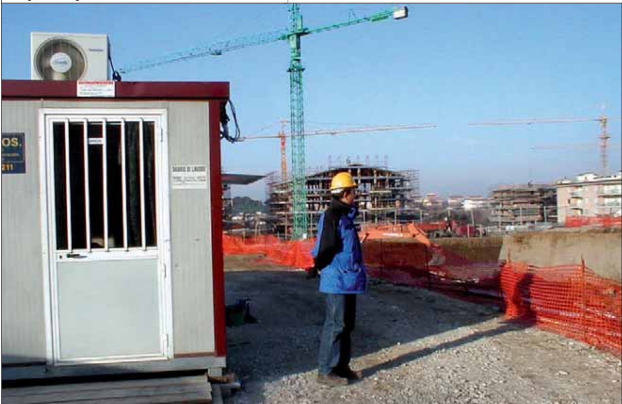
Preposto in prossimità della baracca di cantiere
