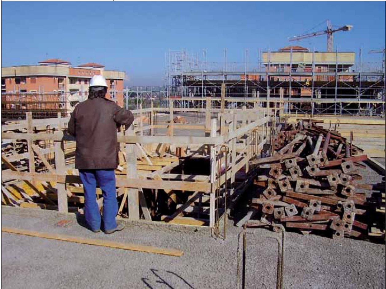
Protezione apertura di solaio
