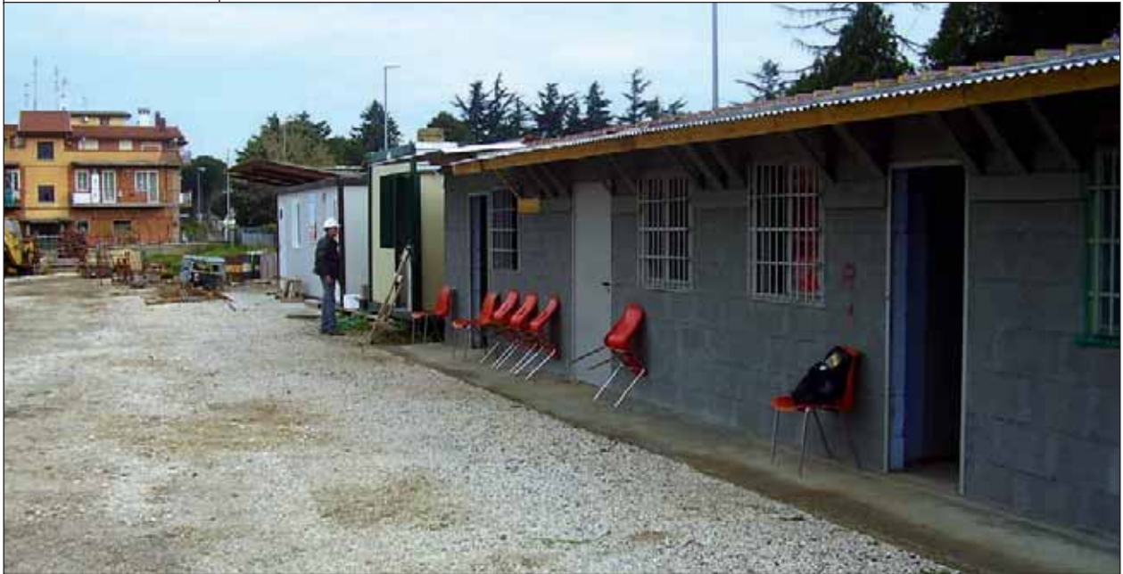
Servizi di cantiere
