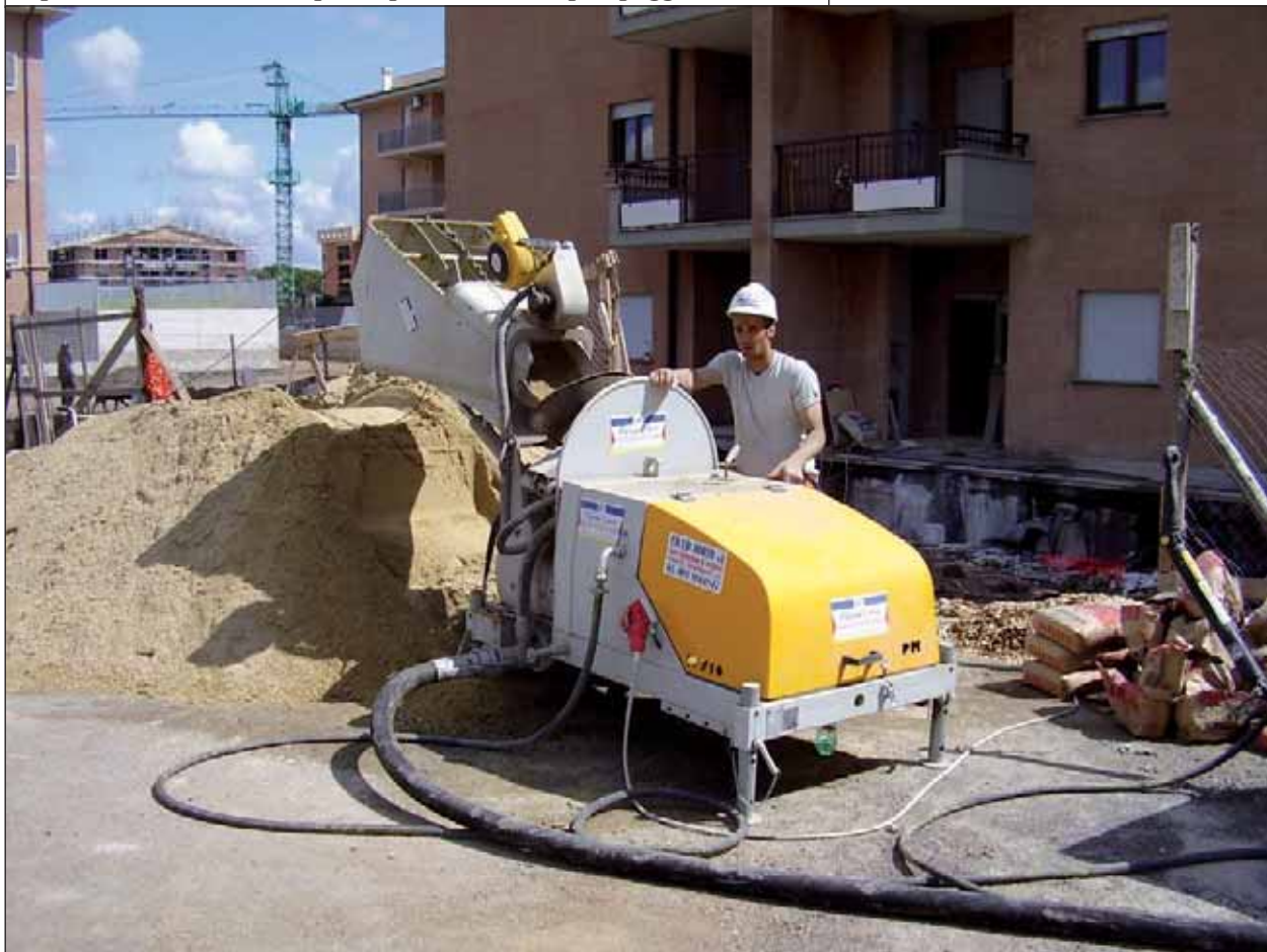
Operatore alla macchina per la produzione e il pompaggio di malte
