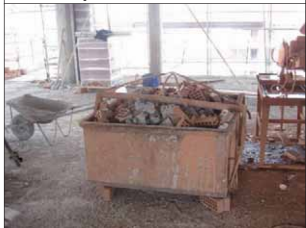
Contenitore per materiali di risulta
