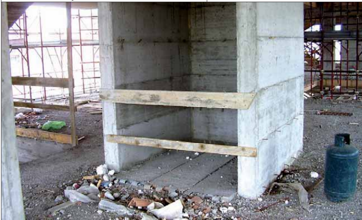
Vano ascensore con piattaforma di sicurezza e sbarramento
