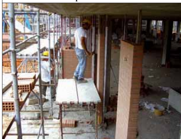
Ponte a cavalletto a piano terra
