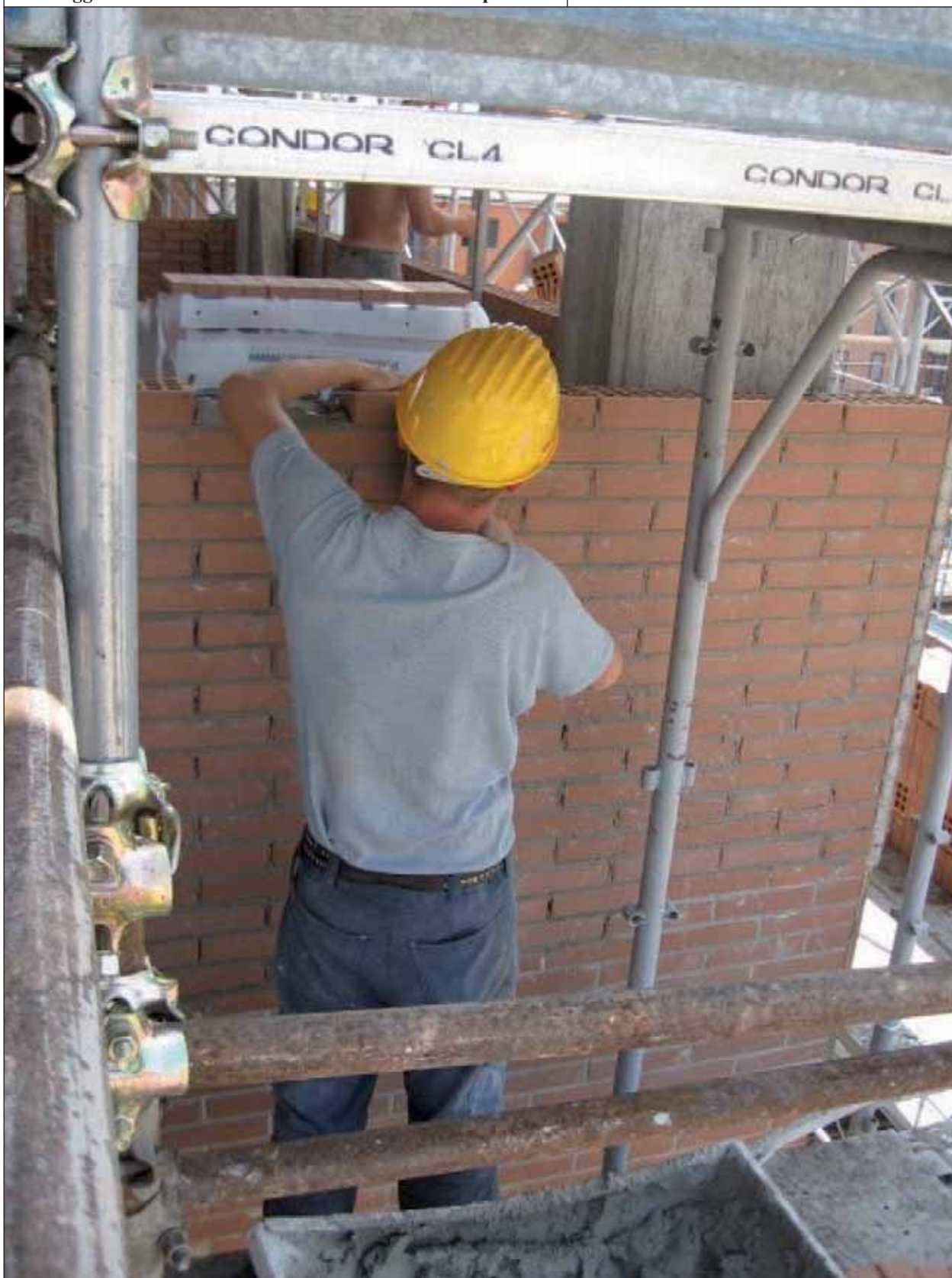
Montaggio della cortina all'altezza della visuale dell'operatore
