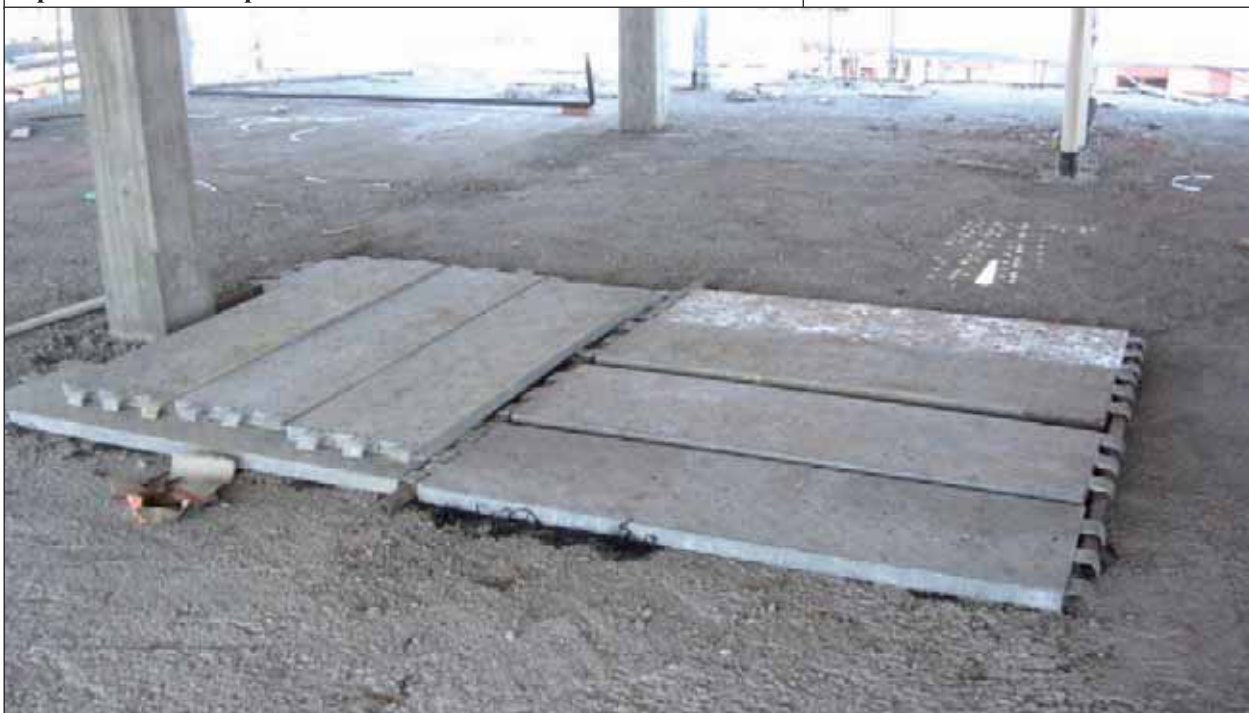
Apertura sul solaio protetta con tavole metalliche fissate al cemento
