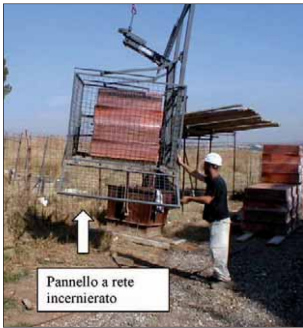
Sequenza rotazione e chiusura pannelli inferiori gabbia e sollevamento in quota
