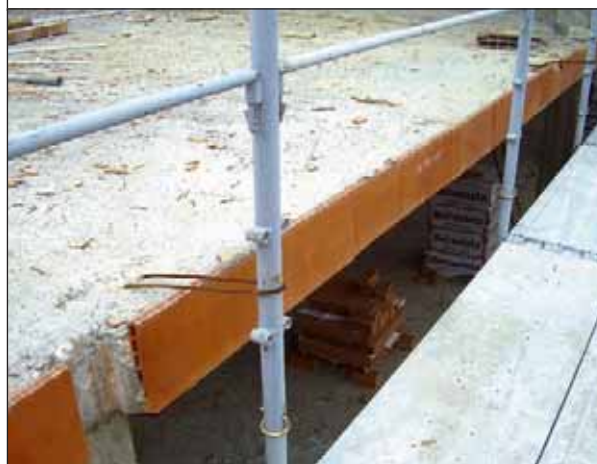
Tavellina d'isolamento termico su fronte solaio
