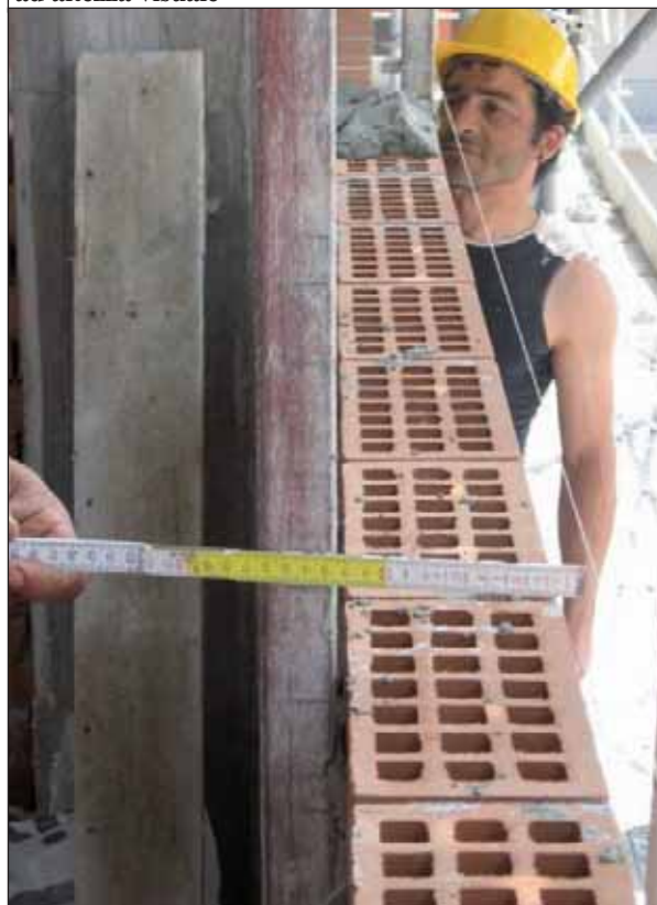
Filo a livella, calandri e cortina montata ad altezza visuale
